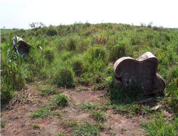
Photo 1: Culées d'iroko abandonnées
